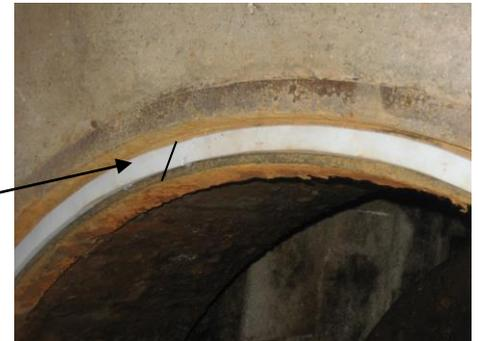
**Die bestehende Vollgummi-Dichtung muss unbedingt durch die mitgelieferte weichere Moosgummi-Dichtung 15x12mm ersetzt werden, damit die Abdeckung ebenerdig und wasserdicht schliesst**
