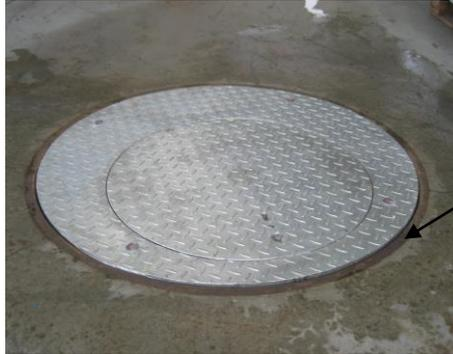
Von Roll Dichtung ersetzen
