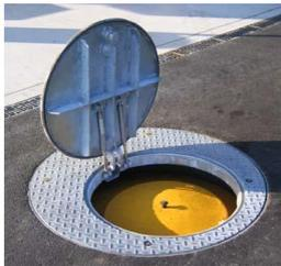
Dies hat den Vorteil, dass die Abdeckung, auch später, in jede Position gedreht und befestigt werden kann und genau auf die dezentrale Oeffnung des Kunststoff-Innenschachtes angepasst werden kann.
