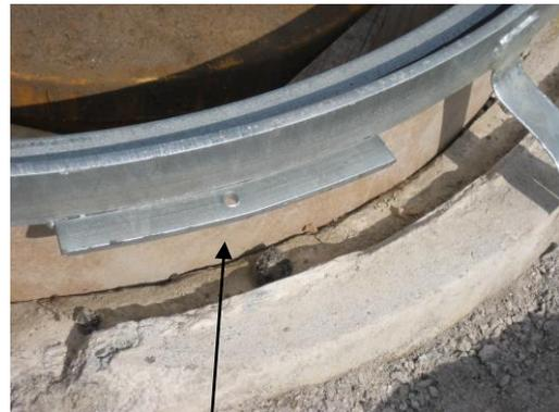
**Loch** Ø 8.5 mm zum befestigen im Betongitternetz oder für die Höhenverstellung
