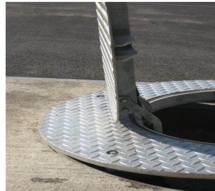
Durch Herunterdrücken und gegen die entgegen gesetzte Scharnierseite so weit schieben, dass die Platte einige Zentimeter ausserhalb dem Ring liegt. (Sicherheit, damit sie nicht in den Schacht rutschen kann)
