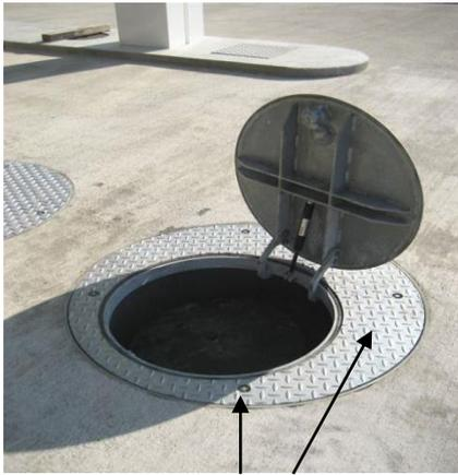
Lösen der vier Schnellverschluss-Riegel (Vierteldrehung)
