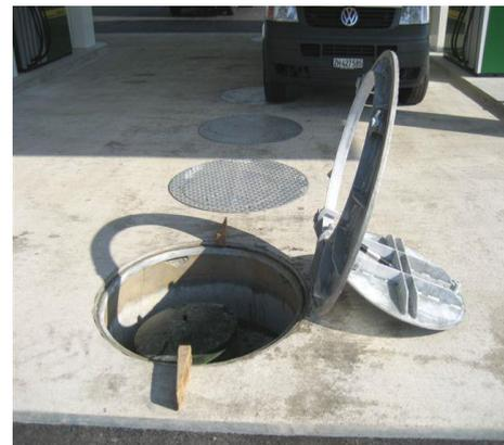
Von der Öffnungsseite wiederum die Platte ganz anheben und soweit überkippen, bis sie an der geöffneten Serviceabdeckung ansteht und sicher positioniert ist. Beim Schliessen in umgekehrter Reihenfolge vorgehen.
