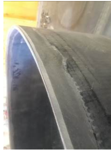
Repaired belt edge
