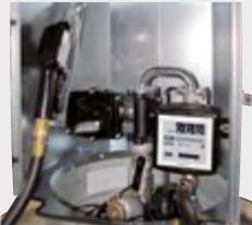
Elektropumpe, ca. 40 l/min, mit Zähler, ATEX, 230 V, mit Automatik-Zapfpistole, 4 m Befüllschlauch |  | 10260     | 1.560,-    |
