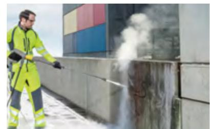
Hochdruckreinigung mit bis zu 200 bar
